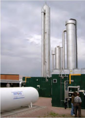
**Abb. 19: Biogasaufbereitungsanlage mit Druckwasserwäsche, Standort: Könnern I**
