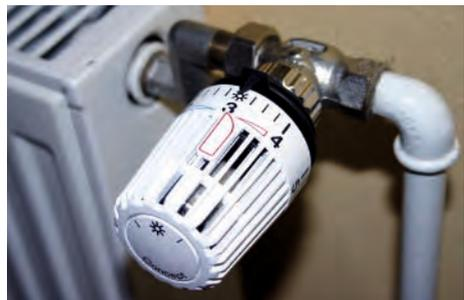
Abb. 37: Thermostat zur Wärmeregulierung
