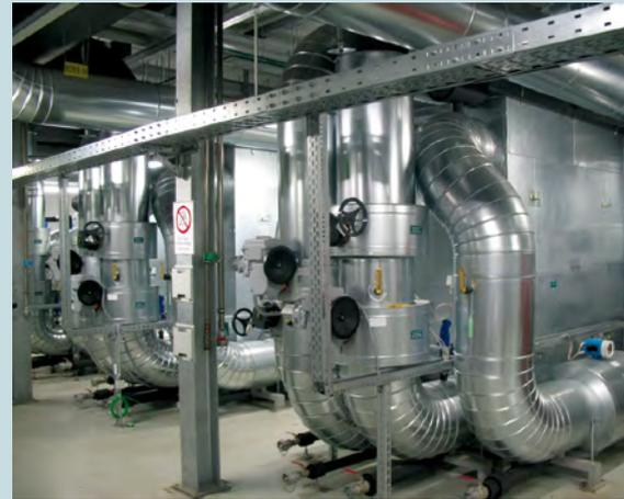
Plattenwärmetauscher in der Energiezentrale des FIZ (Forschungs- und Innovationszentrum BMW)
